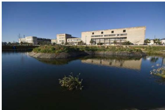
El sistema consta de dos lagunas en serie: una primera facultativa y una segunda de maduración. La planta sirve a 6 edificios equivalentes a una población de unos 5.000 usuarios potenciales, cuyo
