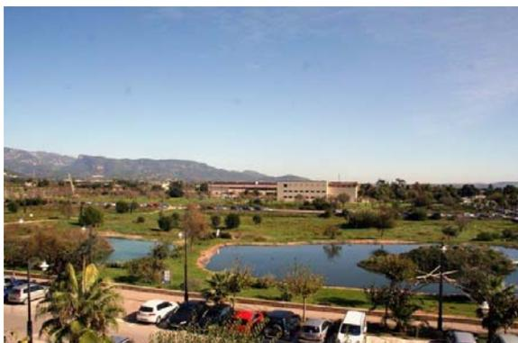
El diseño de las lagunas es circular con formas orgánicas, con un *baffle* en el centro a modo de isla. De esta manera se pretende forzar la circulación del agua, y así aumentar el Tiempo de Residencia Hidráulico (TRH) en la laguna, minimizando el requerimiento de superficie.
