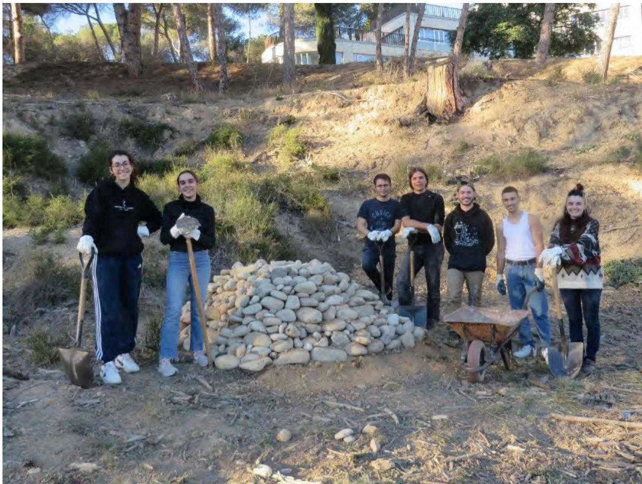
Figura 38: Construcción de un refugio para reptiles en la Universitat Autònoma de Barcelona
