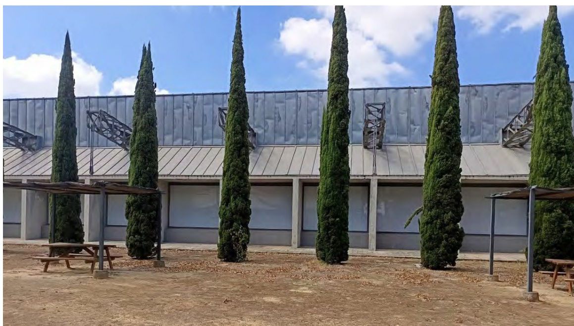
Figura 48: Efecto del vinilo blanco perforado sobre el exterior e interior de la biblioteca de la Universidad Pablo de Olavide (foto superior) y visión general del efecto del vinilo sobre los ventanales de la biblioteca (foto inferior).
