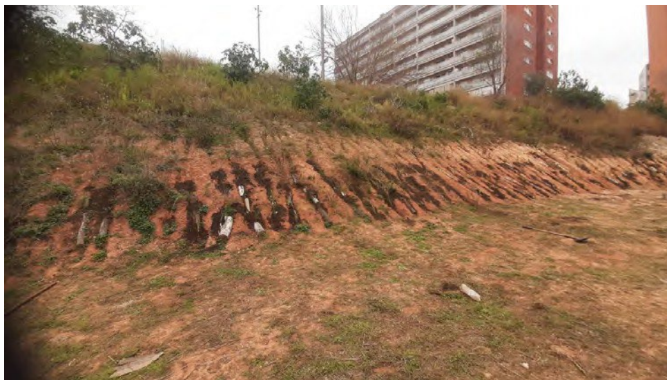
Figura 19: Fase II de la restauración de un talud en la URV
