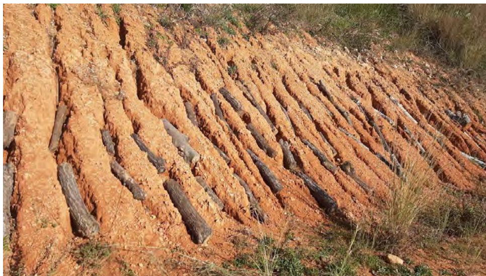
Figura 18: Fase I de la restauración de un talud en la URV
