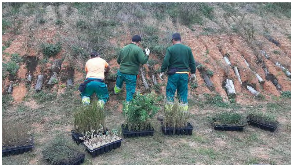
Figura 20: Fase III de la restauración de un talud en la URV
